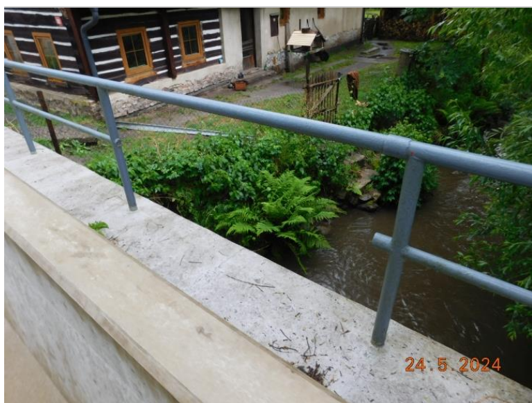
Chybějící spodní madlo zábradlí na pravé římse.
