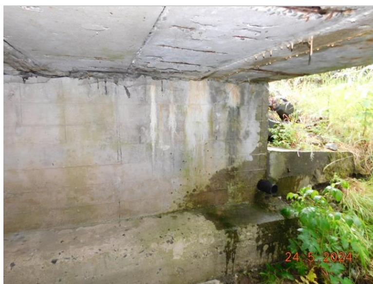
Levá část opěry OP1, stopy po zatékání s výluhy pojiva, průsak v dolní části.
