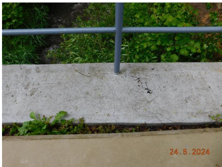
Příčná trhlina na levé římse.
