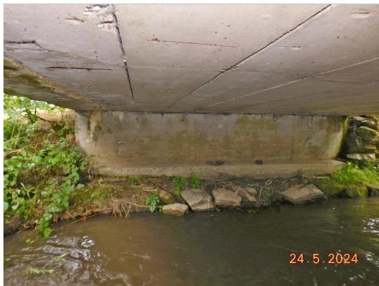
Pohled na opěru OP2, podhled nosné konstrukce.
