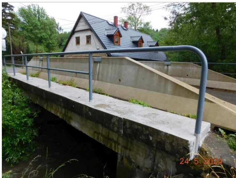
Chybějící spodní madlo zábradlí na levé římse.
