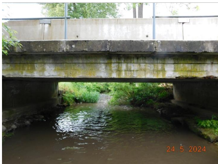
Pravý bok mostu. V pravé části separace krycí vrstvy na dolním lici krajního nosníku.
