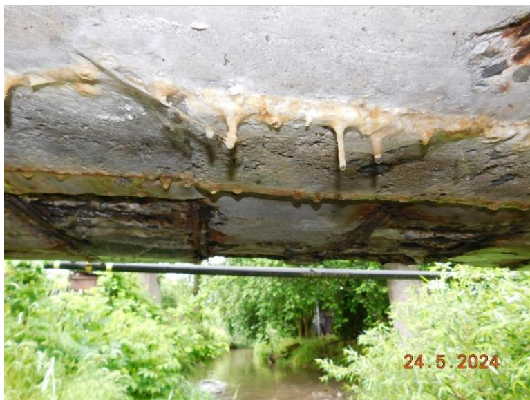
Zatékání spárami mezi krajními nosníky - výluhy s inkrustacemi.
